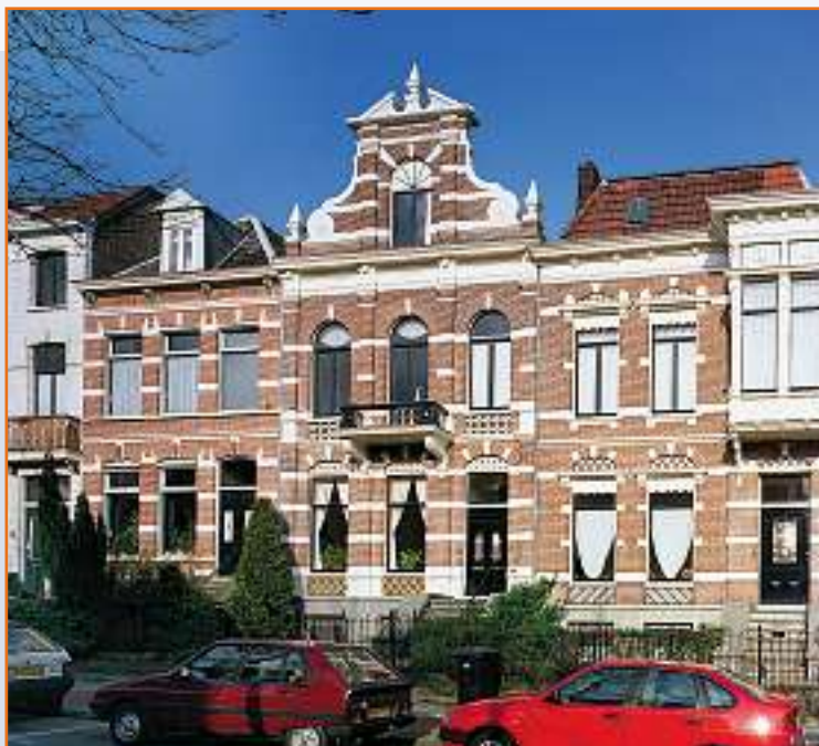
Apeldoornseweg 20-22, na de restauratie van de voorgevels in 1994.
